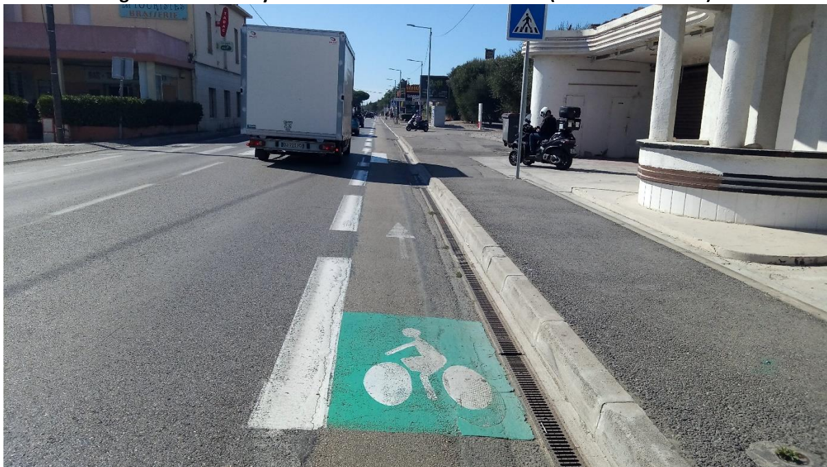
Figure 4.3 : Voies cyclables non sécurisées sur la RN7 (Villeneuve Loubet) 110
